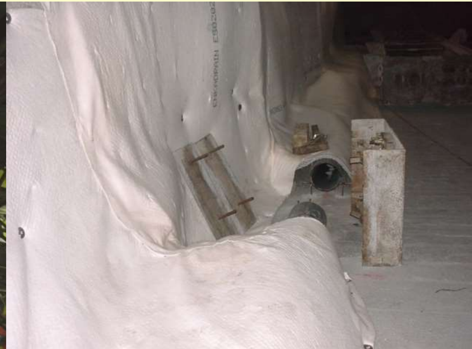
Raccordement géogrille
