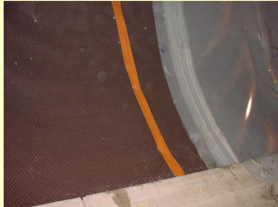
Drainage et étanchéité
