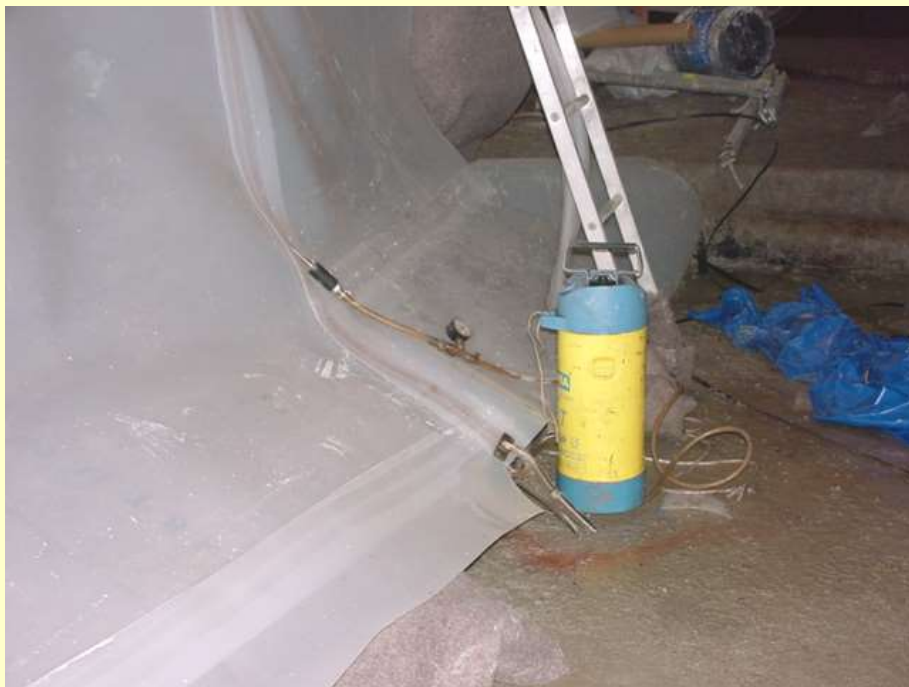
CONTRÔLE PAR MISE EN PRESSION
