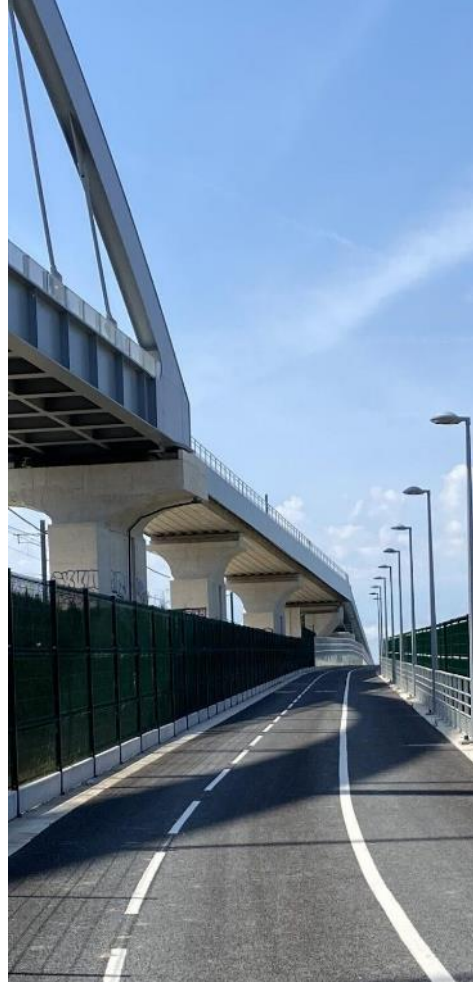
Passerelle Eole Nanterre (92) – Bezons (95)
