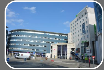
Rayonnement de la gare de part et d'autre des voies ferroviaires Le Mans, 2015
