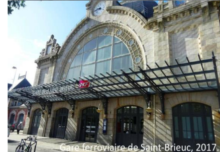
Gare ferroviaire de Saint-Brieuc, 2017.
