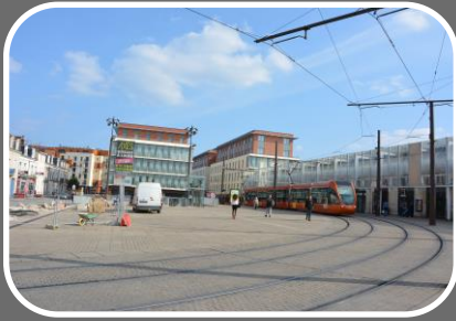
Aménagement d'un pôle d'échange multimodal Le Mans, 2015
