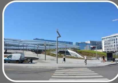
Réaménagement du parvis de la gare Rennes, 2021
