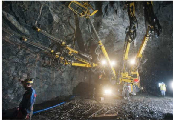
Figure 1.1. Abattage à l'explosif en pleine section - Jumbo de foration (Atlas Copco)
