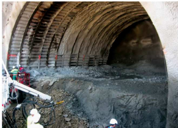
Figure 1.2. Tunnel 186 - Creusement traditionnel en demi-section
