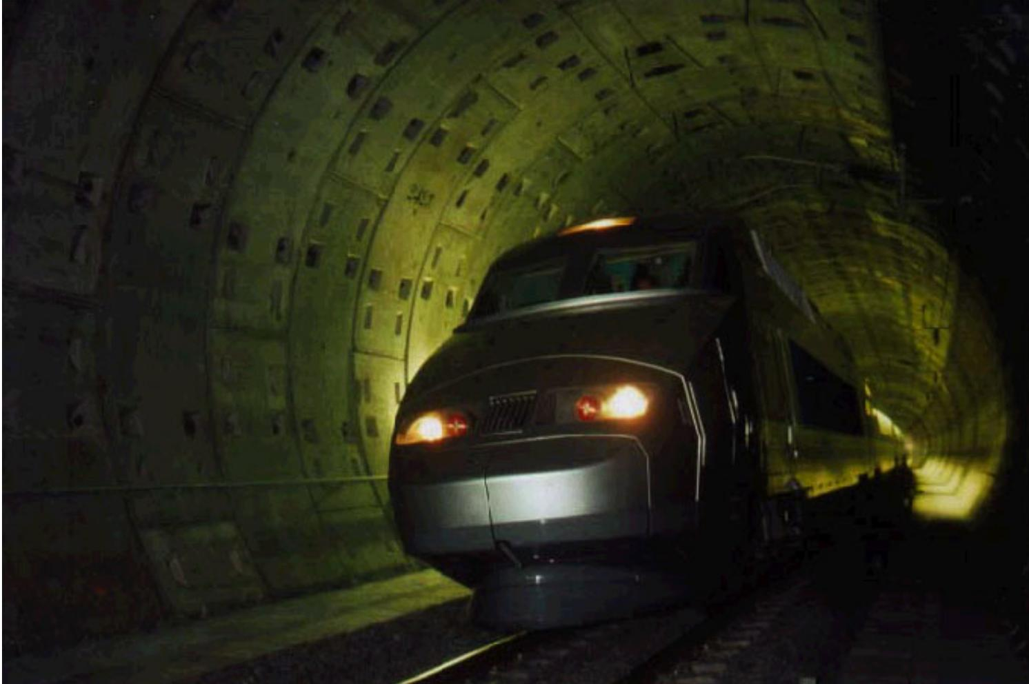
Exemple d'aspect intérieur d'un tunnel réalisé au tunnelier : tunnel TGV de Villejust
