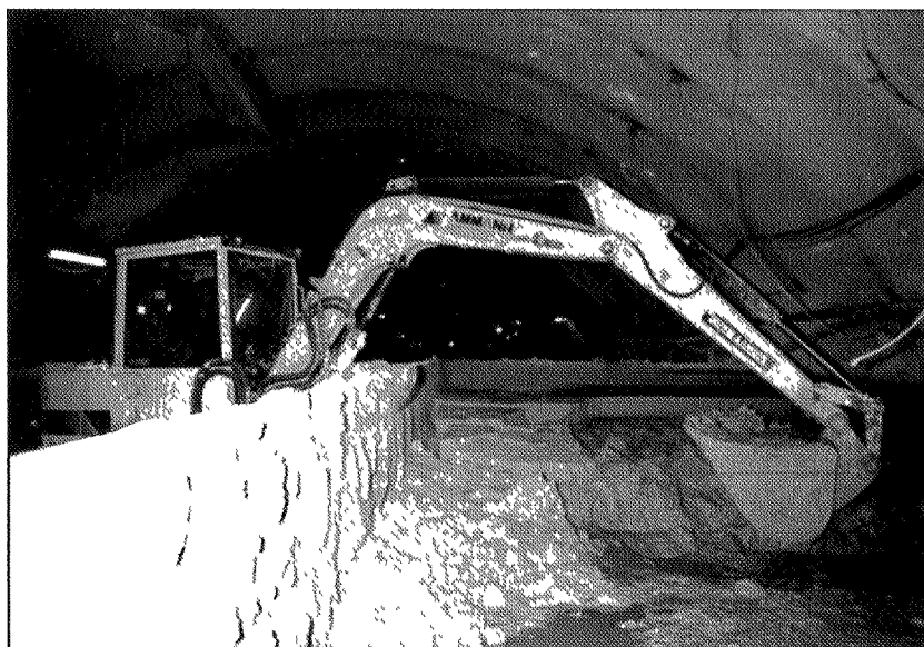
Figure 14 - Evacuation du spoil solidifié
