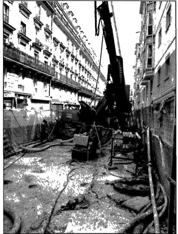
Figure 16 - Jet grouting depuis la rue Demarquay
