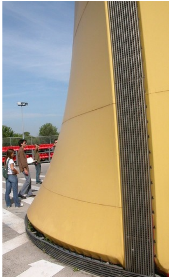
Œillets + chéneau structurel
