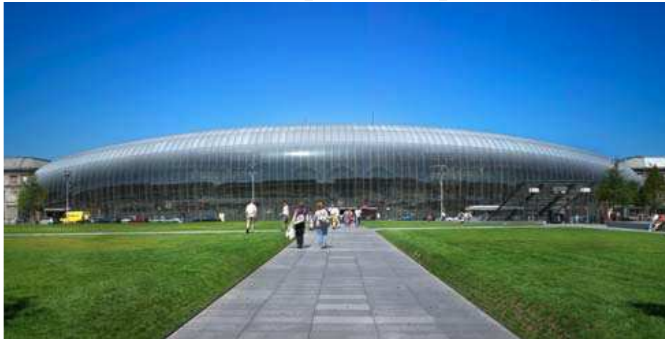
Gare de Strasbourg – panneaux cintrés à froid (image: RFR)
