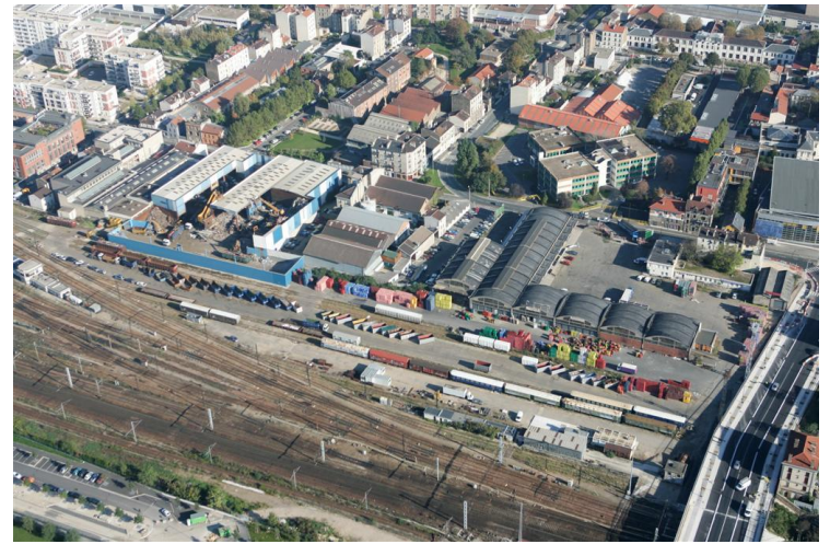
Exemple: le long des voies ferrées (site Sernam)
