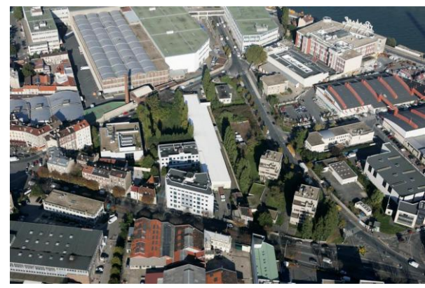
Exemple: les tours Riboulet, inscrites à l'inventaire des Monuments Historiques. Projet de réhabilitation en logements – Travaux dès 2011
