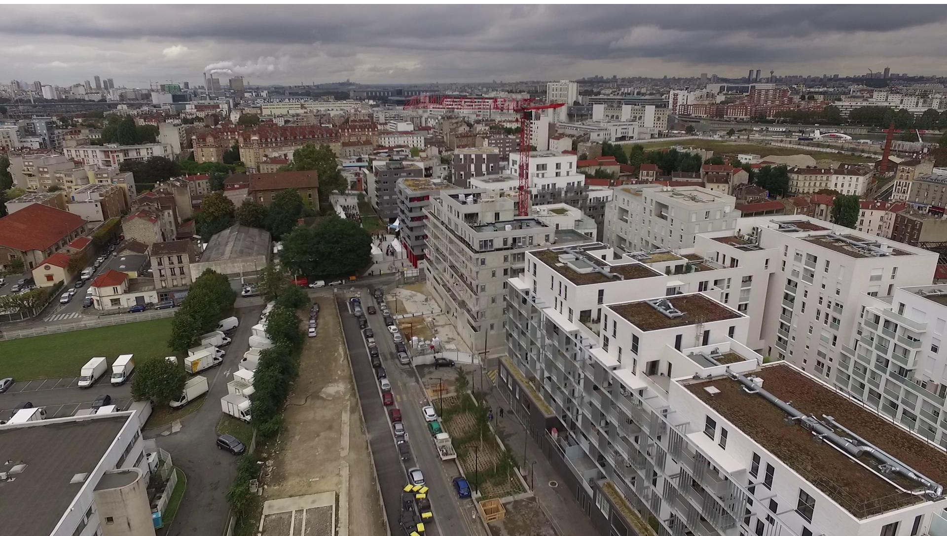
Nouveaux logements, voirie rue des Lampes
