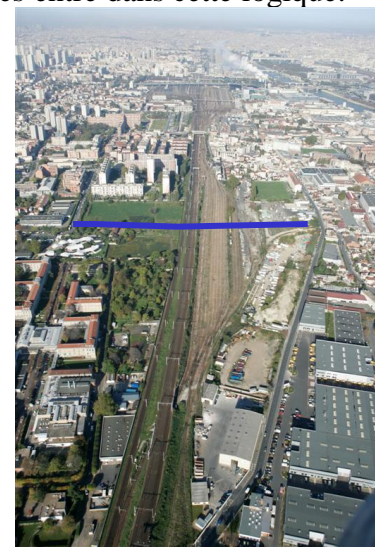
Exemple: Nouveau pont au dessus des voies ferrées
