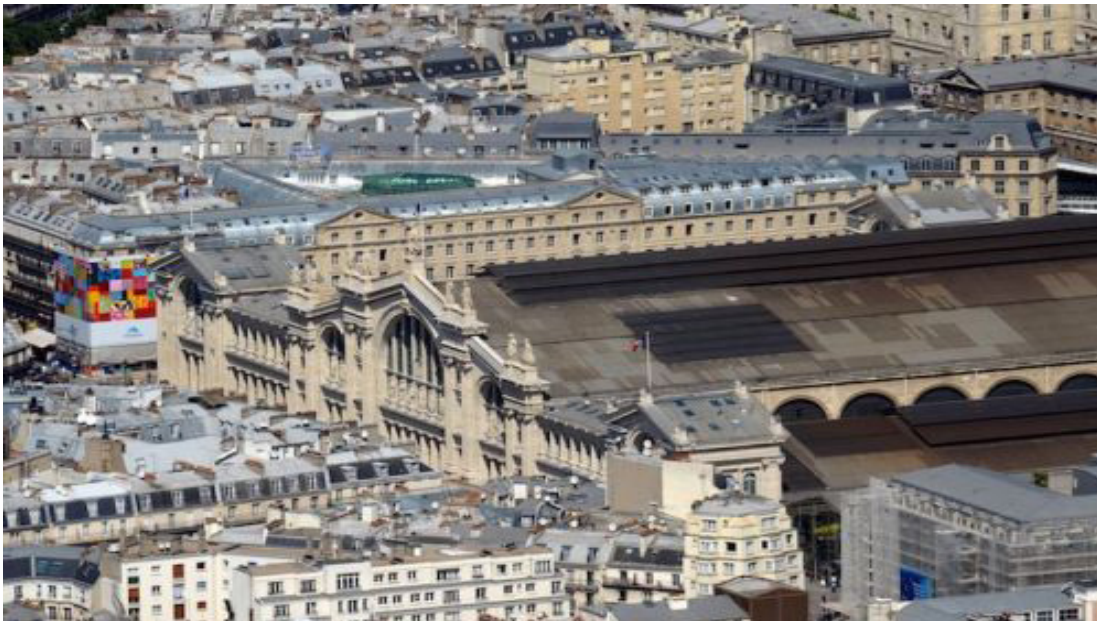
La gare du Nord dans le tissu urbain environnant
