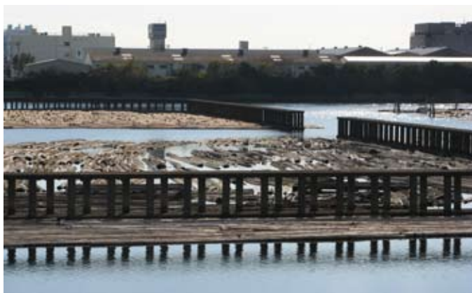
Bassin intérieur nord
