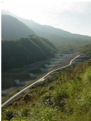
Barrages SABO en escalier pour ralentir les écoulements de coulées de débris © C. Gomez, 2004
