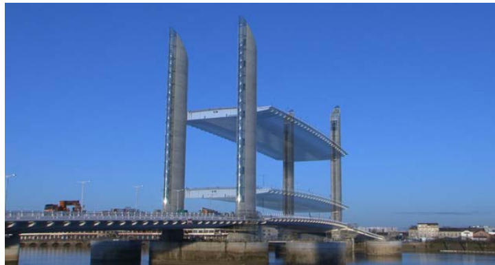
Le Pont Jacques Chaban-Delmas à Bordeaux (source : Caisse des Dépôts et Consignation)
