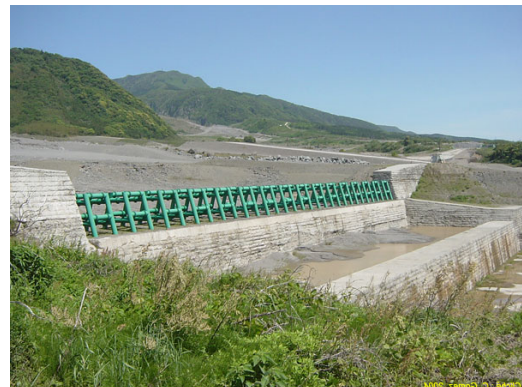
Barrage Slit au dans la vallée Mizunashigawa avec un bassin de collecte des sédiments plus fins en aval. © C. Gomez, 200
