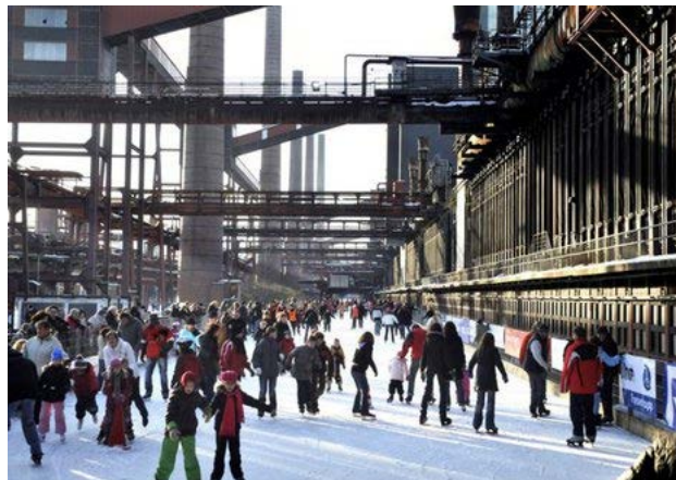
Transformation d'une usine en patinoire
