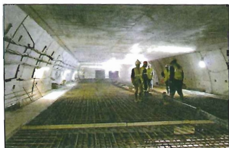
Figure 11 - Préparation pour un bétonnage d'un plot central de dalle médiane
