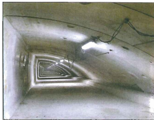
Figure 10 - Vue de la gaine d'extraction supérieure et de la cloison haute
