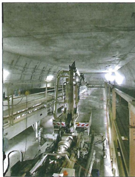
Figure 12 - Bétonnage d'un plot de dalle médiane
