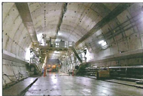
Figure 9a - Coffrage des corbeaux
