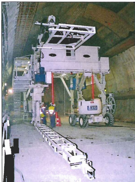
Figure 8 - Portique de ferrailage baptisé Popeye
