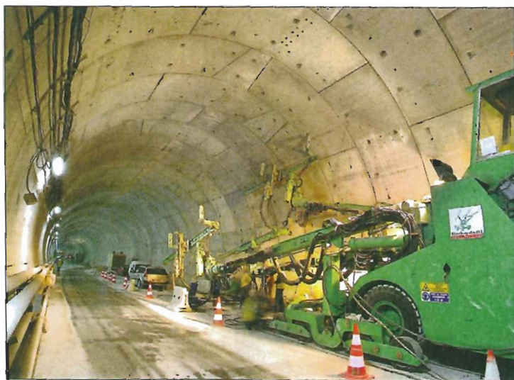
Figure 6 - Forage au RoboFore pour scellement des attentes
