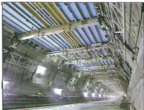
Figure 9 - Coffrage de la dalle haute
