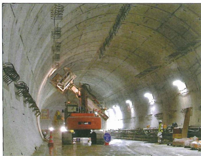
Figure 7 - Raboteuse pour reprise de la surface des voussoirs
